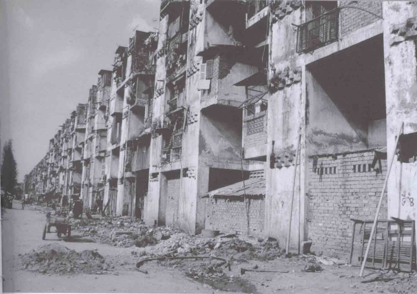
Façade ouest: malgré la dégradation, l'architecture reste remarquable.
