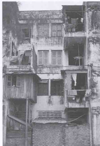
Construction sur pilotis.
