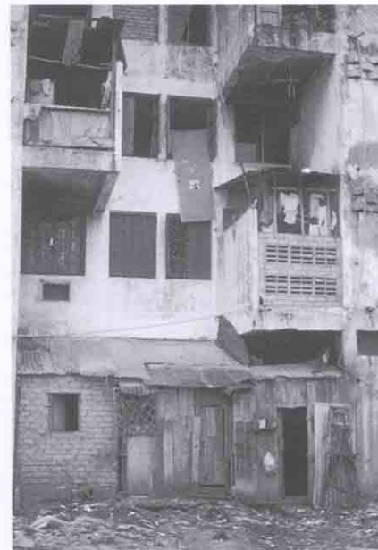
Fermeture et agrandissement des rez-de-chaussée.
